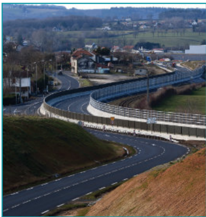
Travaux RN122 Ouverture du contournement Sud d'Aurillac
