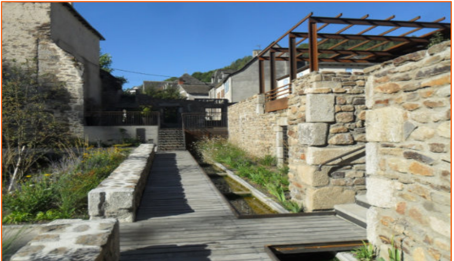
Chaudes-Aigues, aménagement d'un parc urbain sur un ancien îlot insalubre en espace protégé, accompagnement et suivi du projet et du chantier. Plantes vivaces d'essences locales, matériaux locaux biosourcés (bois et pierre), parcours d'eau pour découvrir les sources chaudes.
