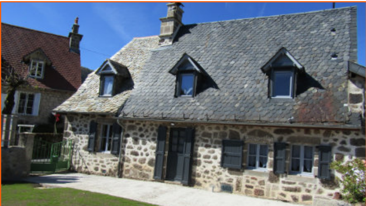
Dossier Anah : réhabilitation d'une maison vacante très dégradée.
