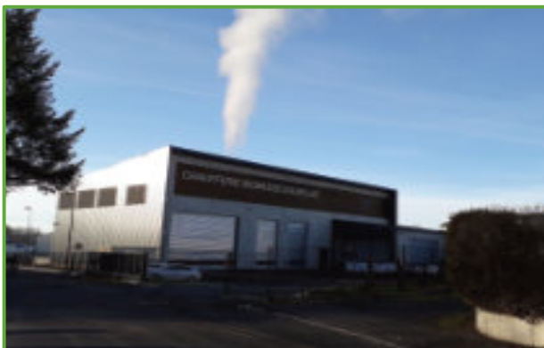
Chaufferie ACB Aurillac et ses 4 cheminées
